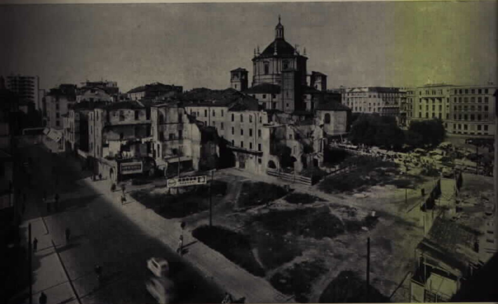
78 - Veduta delle zone di S. Lorenzo, da via Molino delle Armi a piazza della Vetra. Le aree rese libere dalle ingenti distruzioni belliche si stanno trasformando in parco pubblico, secondo le previsioni del Piano.
